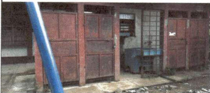
Foto 1: Este modulo de baños no cuenta con mingitorio, por lo que un tasa se eliminará y se construirá un mingitorio de concreto.
