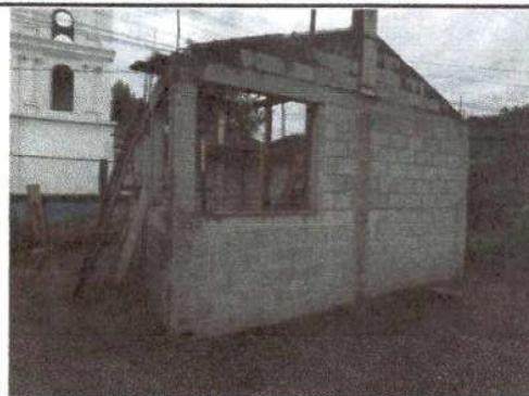
Foto 2: Esta cocina escolar solo cuenta con pared. Gracias a esta ayuda se le colocará piso, ventanas, puertas, plancha, energía eléctrica, labadero y se techará.
